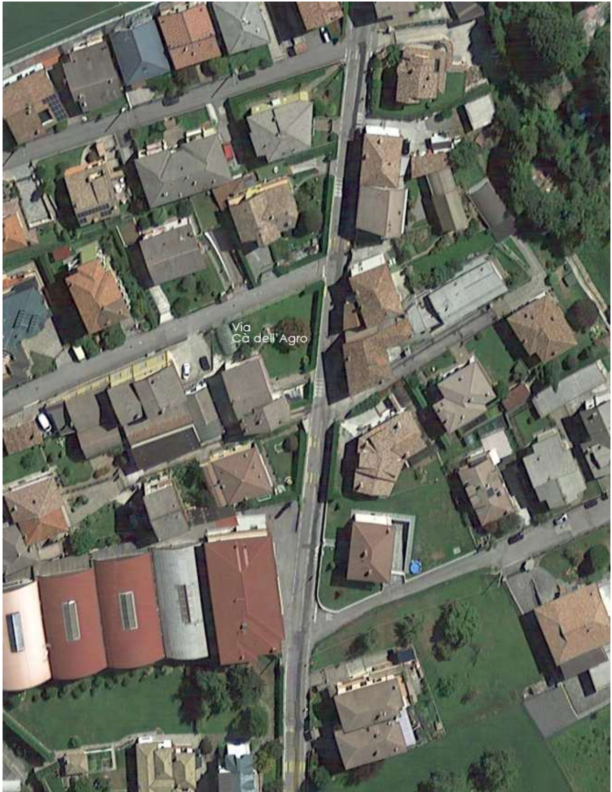
Via Cà dell'Agro (tratto compreso tra Via Isonzo e Civ.70).
